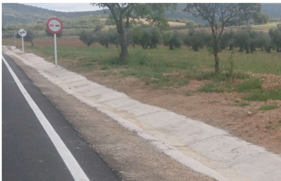
Imagen 9: Ejemplo de cuneta revestida
