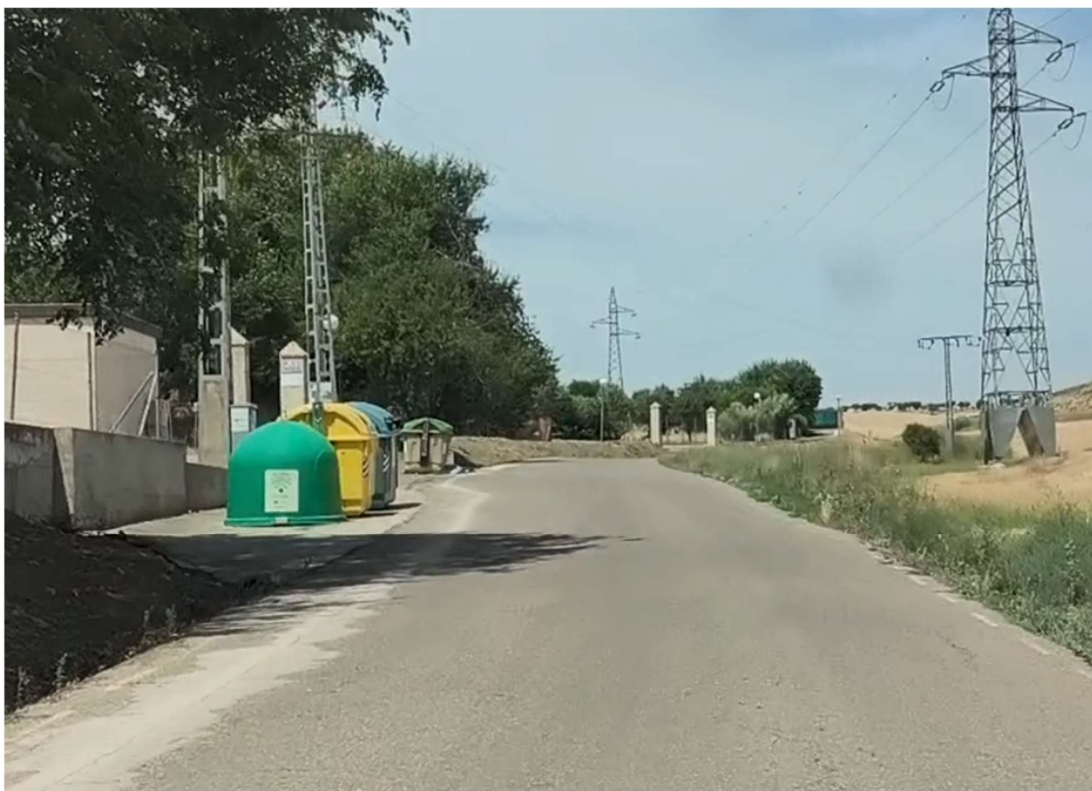
Imagen 4: finalización del itinerario peatonal en la entrada a la urbanización
